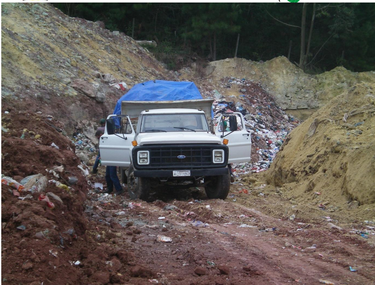
Figura 9: Trincheira utilizada para disposição final dos resíduos e rejeitos
